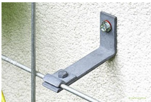
Fot. 1. Sposób mocowania kratki do ściany budynku
